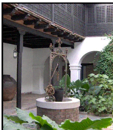
Figura 1. Estado actual del aljibe ubicado en el patio central de la casa de Diego Velásquez en la ciudad de Santiago de Cuba
