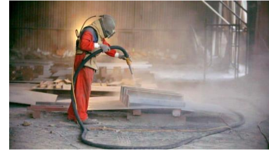
Figura 1. Limpieza a base de granallado en la cámara de Samblasting .
