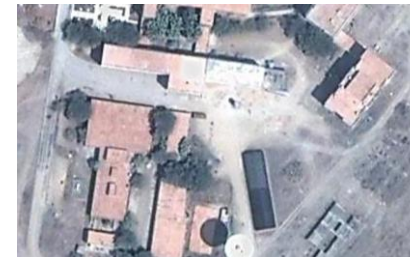
Figura 1: Imagen satelital con Ubicación de la Nave Original e indicación de la Zona de Intervención.
