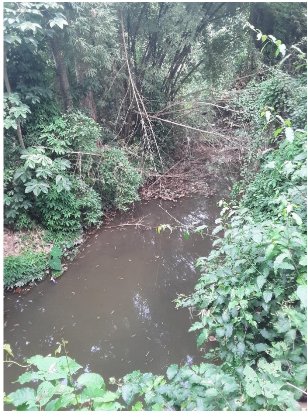
Figura 8. Imagen que muestra la degradación del cauce en el río Los Guaos. Fuente: Fuente: Elaboración propia, (2022).
