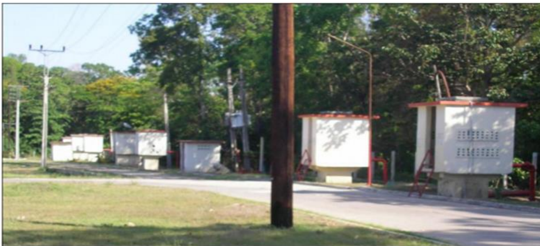
Figura 2Batería de Pozos San Juan
