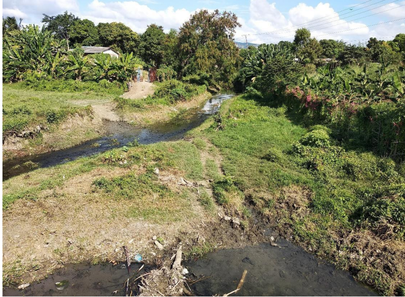
Figura 7. Imagen que muestra la degradación del cauce en el río Gascón. Fuente: Fuente: Elaboración propia, (2022).
