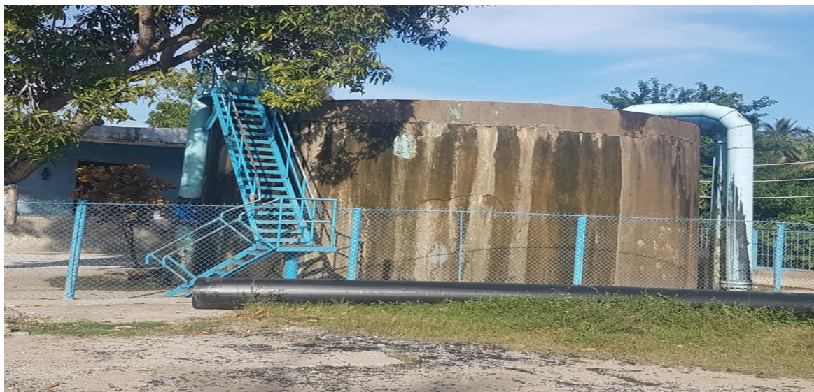
Figura4. Tanque de hormigón circular Camp
