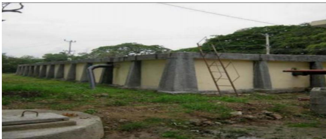
Figura 3 Tanque de hormigón San Juan
