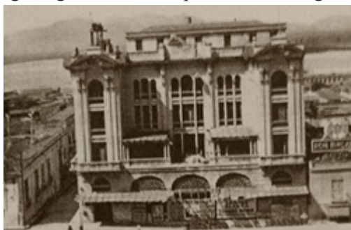
Imagen 4. Hotel Venus, destruido por el terremoto del 3 de febrero de 1932.
