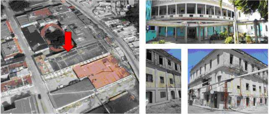
Fig. 2. Vistas actuales del pabellón Pablo de la TorrienteBraou.
